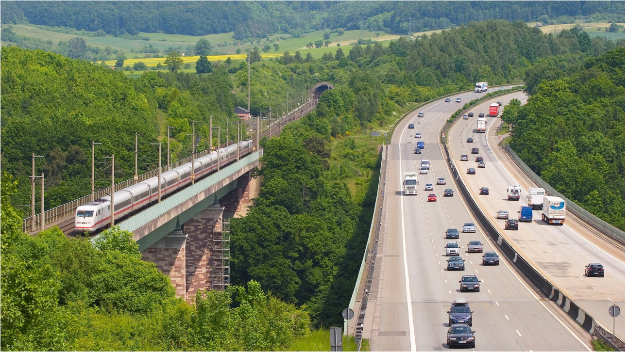
ARCHIV | Foto: DB AG / Bartłomiej Banaszak
