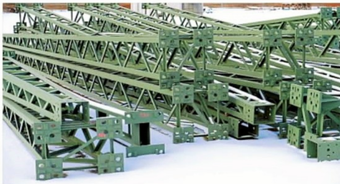
Dutzende Stahlmasten für die Oberleitungen lagern derzeit auf dem alten Sägewerksgelände bei Kall und warten auf ihre Montage. Foto: Thorsten Wirtz
