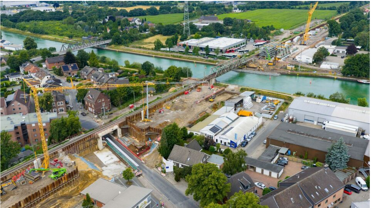
1,5 Meter höher wurde die Bahn-Brücke über den Wesel-Datteln-Kanal gebaut - das hat weitreichende Auswirkungen. (Archivbild) Foto: Christoph Reichwein/dpa
